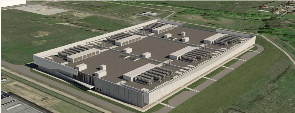
Un data Center d'Orange
